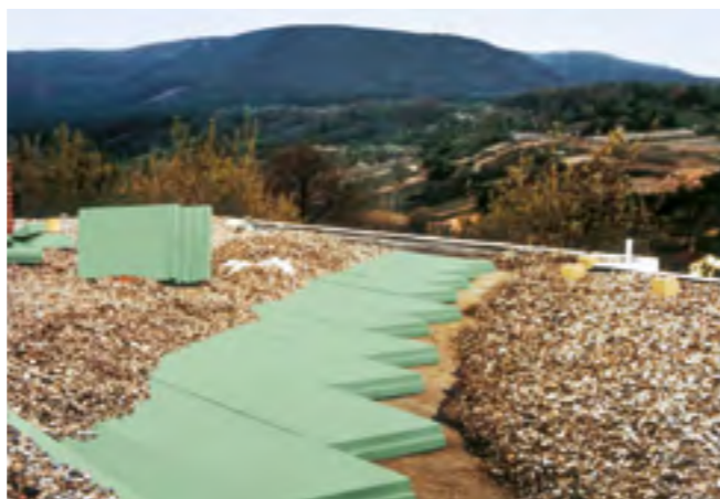
Fig. 18: Tetto rovescio risanato come struttura di tetto-plus.
