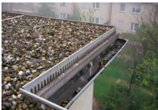
Fig. 19: Tetto a ghiaia.
