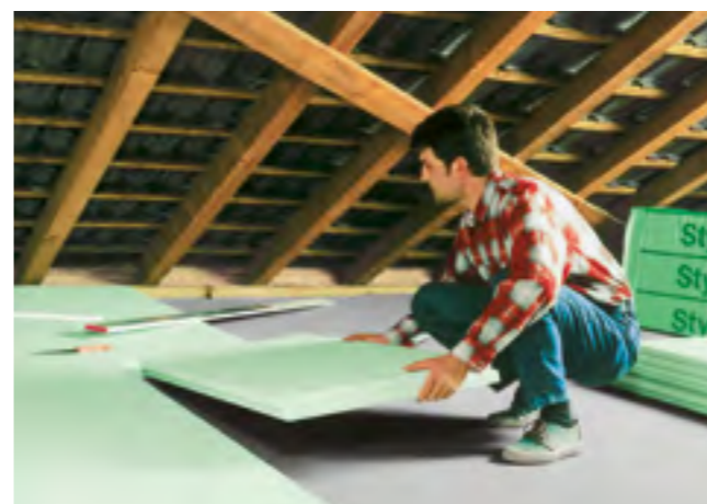
Fig. 10: Isolamento di un sottotetto con Styrodur®.
