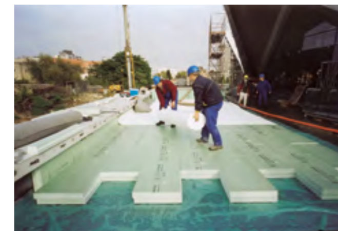
Fig. 16: Posa di Styrodur® sopra all'impermeabilizzazione del tetto.
