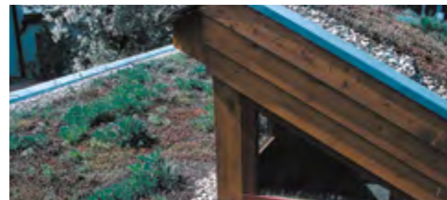
Fig. 27: Rinverdimento estensivo del tetto con piante resistenti alla siccità.
