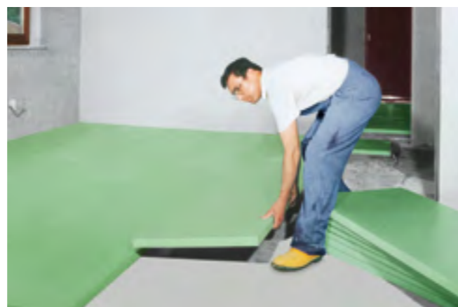
Fig. 18: Isolamento del pavimento della cantina.
