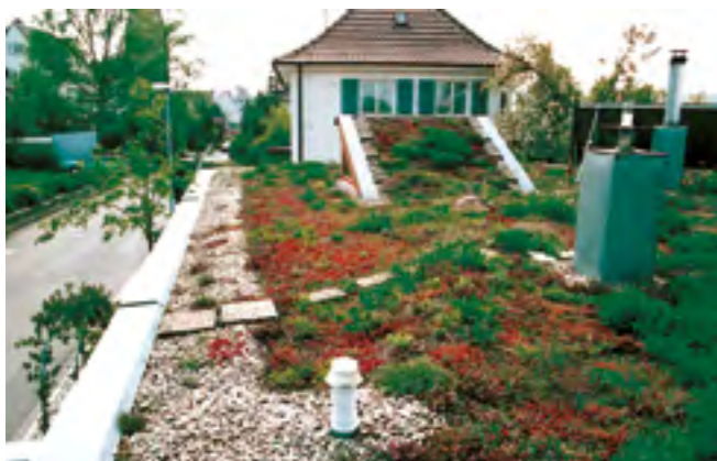
Fig. 36: Strisce di ghiaia sul bordo del tetto e su elementi emergenti del tetto.
