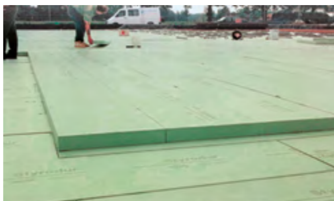
Fig. 8: Posa a vari strati di lastre di Styrodur® sotto la soletta ai sensi dell'Omologazione Z-23.34-1325.
