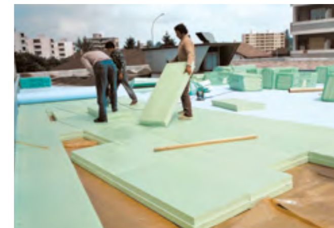
Fig. 14: Posa di Styrodur® per tetto-duo.
