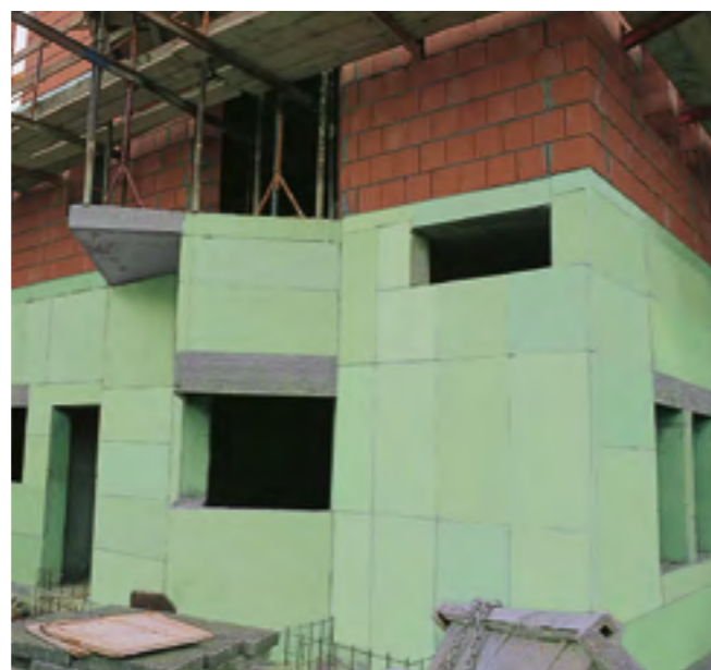
Fig. 25: Isolamento di un pianterreno con lastre di Styrodur® 2800 C.
