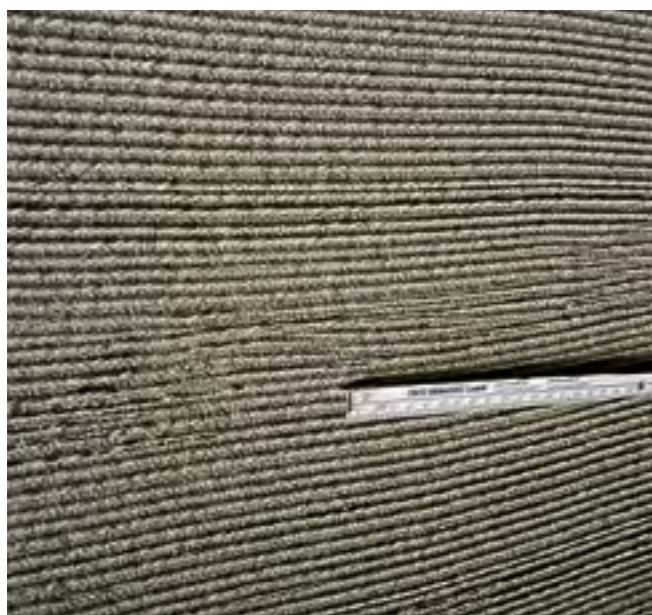
Fig. 24: Stesura orizzontale dello strato adesivo sull'isolamento con Styrodur® 2800 C.
