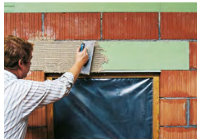
Fig. 20: Architrave della finestra nella muratura da isolare termicamente; stesura orizzontale dello strato adesivo per l'intonaco.
