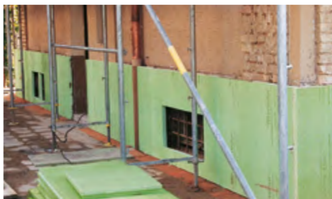
Fig. 17: Successivo isolamento dello zoccolo con Styrodur® 2800 C.
