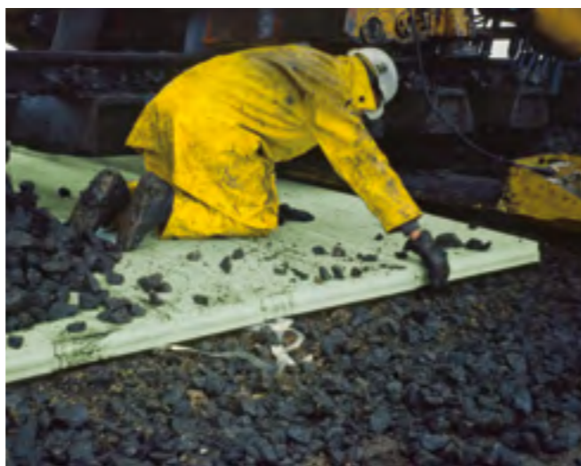
Fig. 9: Posa di Styrodur® nella massicciata ferroviaria.
