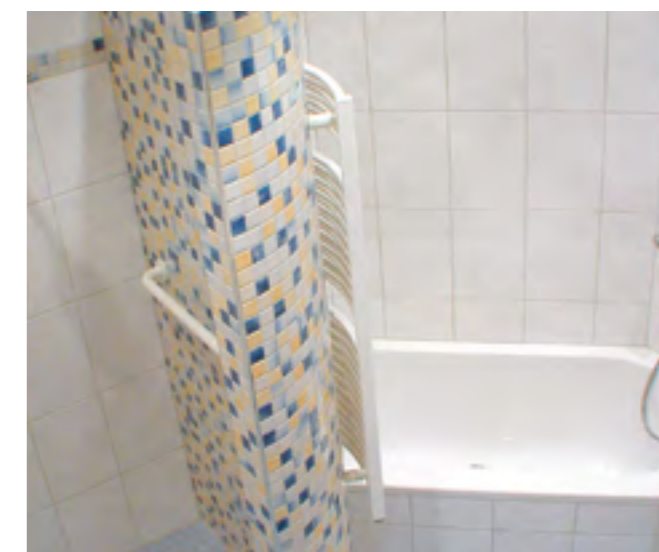
Fig. 35: Esempio di applicazione di elementi piastrellabili in Styrodur®: bagno.
