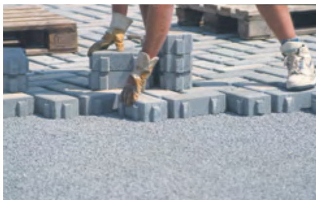
Fig. 39: Tetto rovescio a terrazza con Styrodur®. Posa delle lastre di calcestruzzo su letto di pietrisco.
