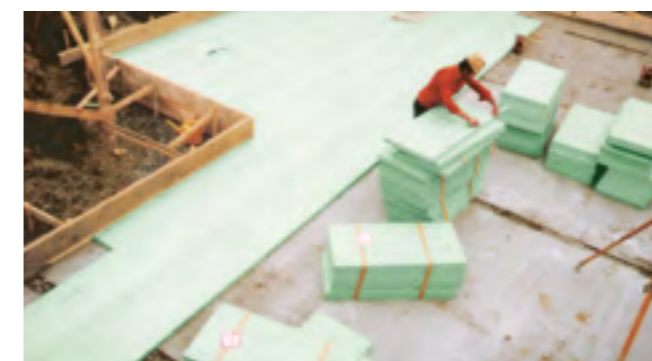
Fig. 4: Posa di lastre di Styrodur.
