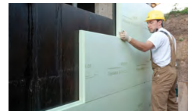
Fig. 4: La posa allineata delle lastre di Styrodur® garantisce un isolamento perimetrale senza ponti termici.
