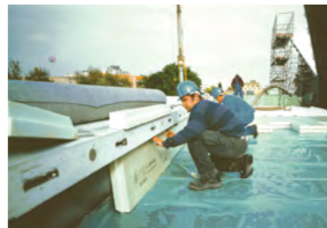
Fig. 15: Isolamento della veletta con Styrodur®.
