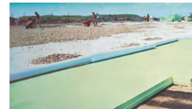
Fig. 11: Tetto rovescio con riporto di ghiaia.
