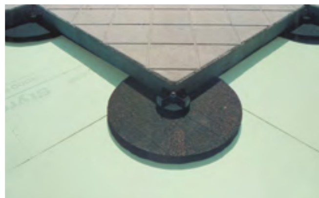
Fig. 44: Lastre di calcestruzzo posate su Styrodur® utilizzando un sistema di supporti.
