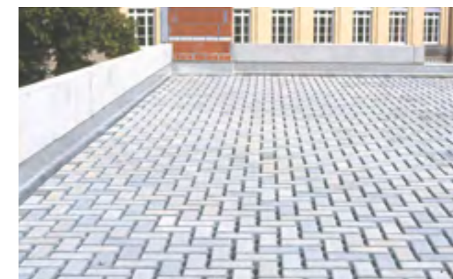
Fig. 49: Pavimentazione autobloccante in calcestruzzo su Styrodur®.
