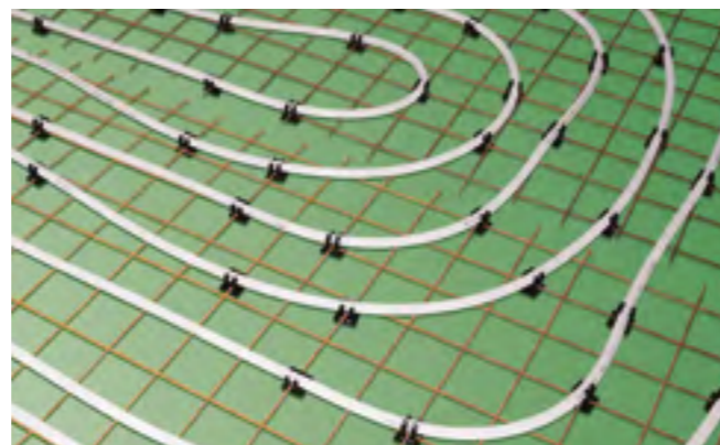
Fig. 19: Isolamento termico con riscaldamento a pavimento.
