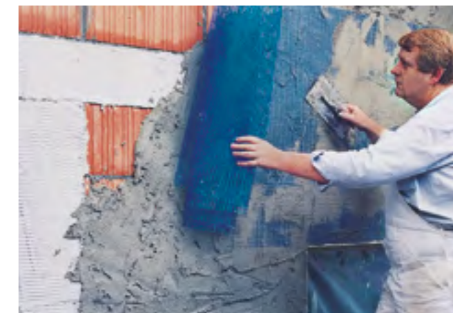
Fig. 22: Applicazione dell'intonaco di fondo e posa dell'armatura con rete in fibra di vetro sugli elementi strutturali in calcestruzzo isolati.
