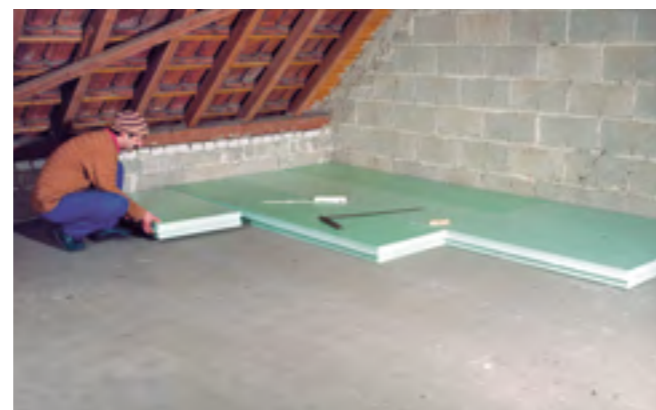
Fig. 2: Isolamento del sottotetto con Styrodur.
