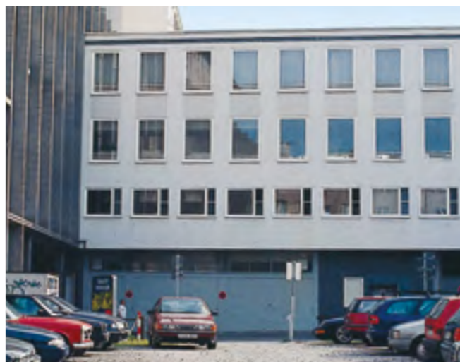
Fig. 5: Ripresa fotografica di un edificio per uffici.
