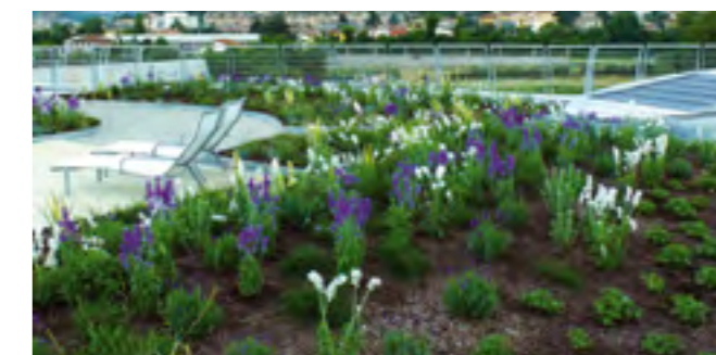
Fig. 6: Tetto verde a terrazza su una struttura di tetto rovescio con strato drenante di ghiaia su tutta la superficie.
