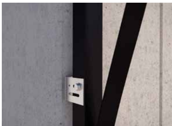
3 _ Applicazione di bandella dielettrica / Application of dielectric band
