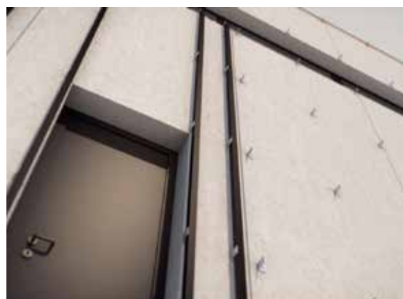
2 _ Fissaggio della sottostruttura alla parete portante / Fixing of the frame to the wall
