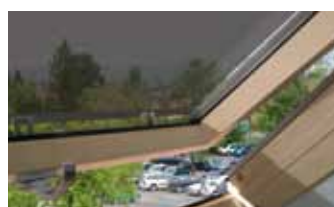
Protezione dall'eccessivo irraggiamento solare con il contemporaneo vantaggio del mantenimento della visibilità (la tenda esterna parasole lascia passare una sufficiente quantità di luce e rende possibile il contatto visivo con l'esterno, perciò non c'è bisogno di avvolgerla tutti i giorni, ma può essere utile proteggere la finestra con la tenda esterna parasole in via continuativa per tutta l'estate),
